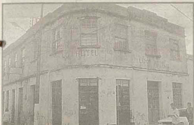
Edificação na confluência da rua Barão do Rio Branco com a praça República Juliana, nos anos 80.
